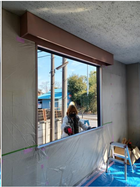
2:外した枠を清掃
